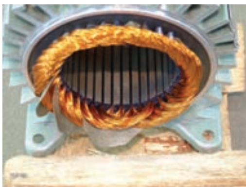
شکل ۲-۳۱- عایق کاری پیشانی کلاف‌ها
