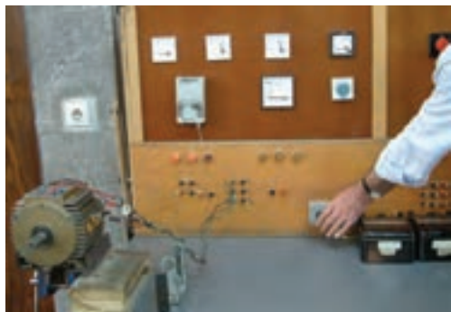
شکل ۹-۶- اتصال موتور به تابلوی برق
