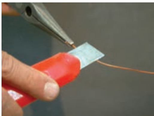
شکل ۴-۱ ج - پاک کردن لاک به روش تراشیدن
