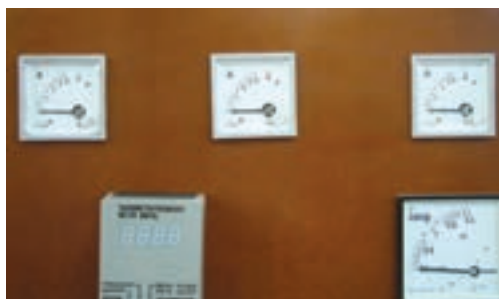
شکل ۶-۱۱- آمپرمترهای اندازه‌گیری جریان فازها
