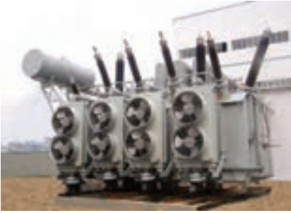
شکل (۳-۱) ترانسفورماتور خطوط انتقال
