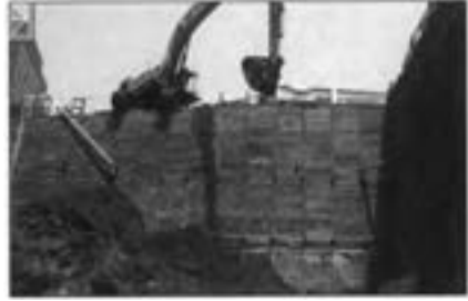
شکل ۱- ضرورت رعایت ایمنی در عملیات گودبرداری
