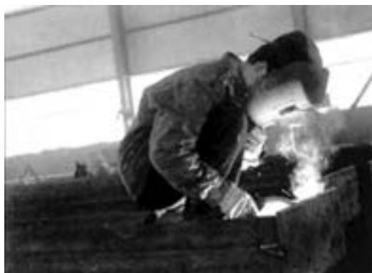
شکل ۲- جوشکاری با الکترودهای روکش دار
