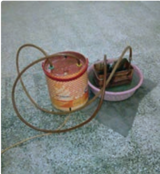
شکل ۲۰- رسوب زدایی مبدل آب گرم کن با دستگاه ویژه
