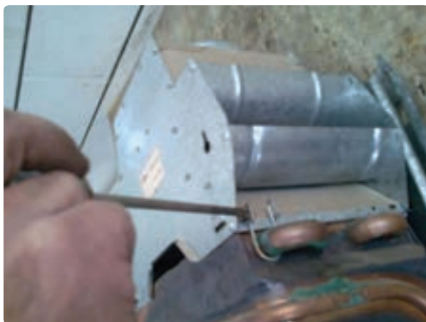
شکل ۶- جدا کردن کلاهک تعدیل از مبدل
