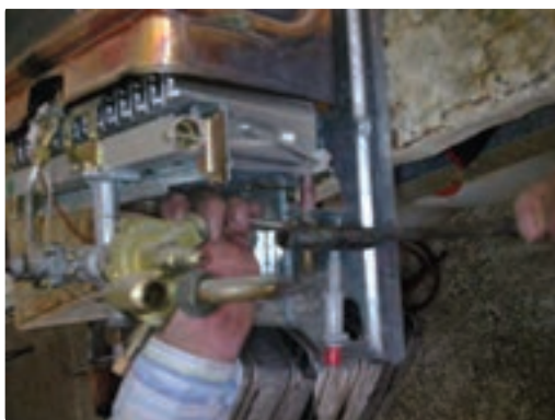
شکل ۸- مبدل گرمایی
