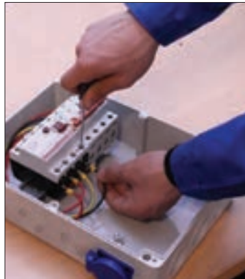
شکل ۲۲- نصب کلید جریان باقیمانده (نشتی)
