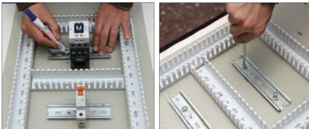
شکل ۸۱- جانمایی و نصب ریل فلزی
