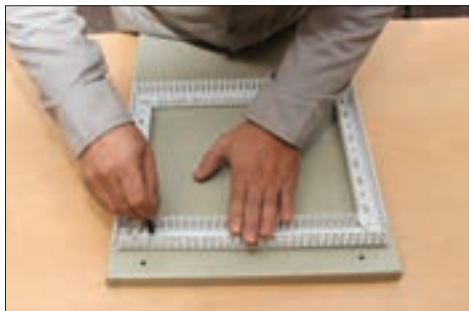
شکل ۴۱- داکت کشی روی صفحه نصب
