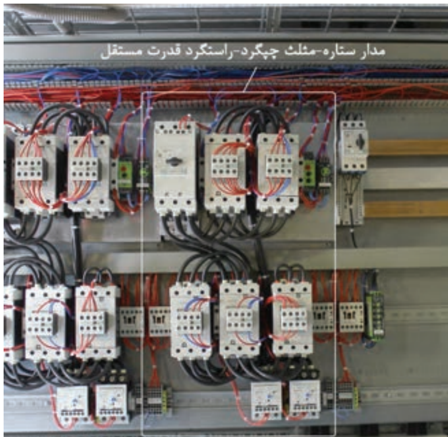
شکل ۴۳- یک نمونه دیگر از تابلو قدرت مستقل
