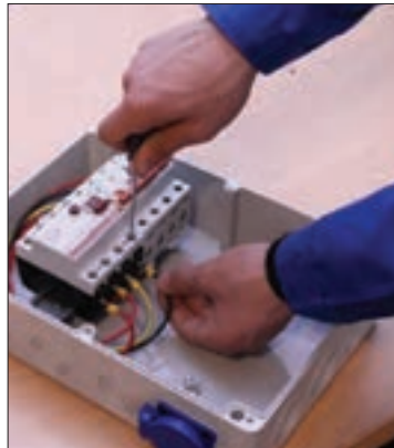
شکل ۲۲- نصب کلید جریان باقیمانده (نشتی)
