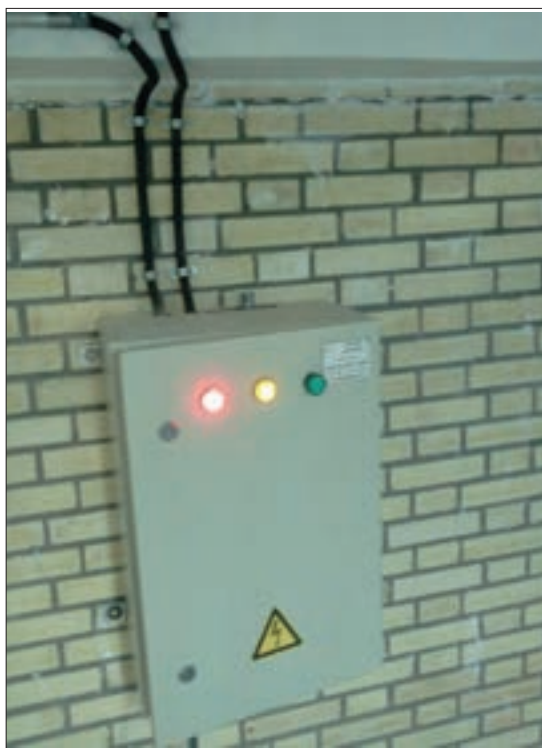
شکل ۲۰- مسیر ورود و خروج کابل‌ها در تابلو
