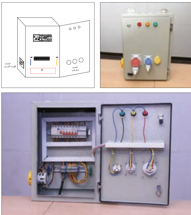
شکل ۵۸- نمای مختلف تابلو توزیع کارگاهی
