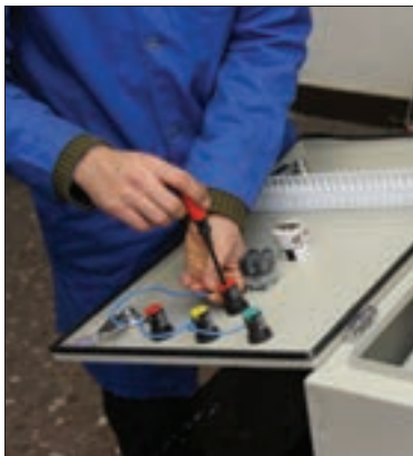
شکل ۹۳- سیم‌کشی چراغ‌های سیگنال
