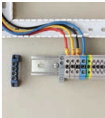
شکل ۵۲- سیم‌کشی روی صفحه نصب
