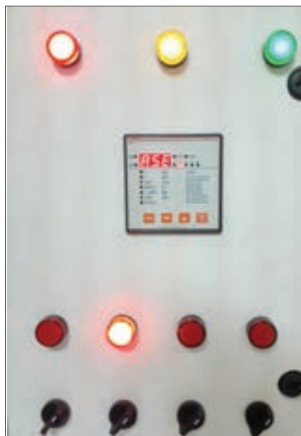
شکل ۲۱- روند شناسایی اتوماتیک توسط رگولاتور
