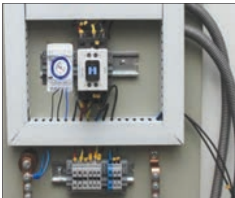
شکل ۱۰۷- محل نصب تایمر ۲۴ ساعت در تابلو روشنایی
