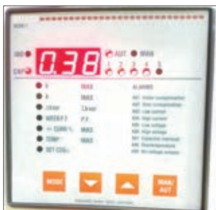
شکل ۲۲- نتیجه عملکرد رگولاتور اصلاح ضریب توان
