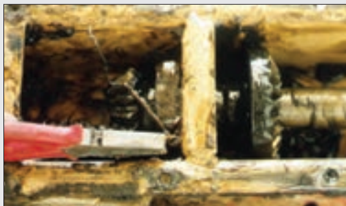
شکل ۲۶- باز کردن سیم مفتولی
