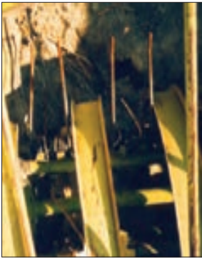
شکل ۹- پایه انگشتی شکسته
