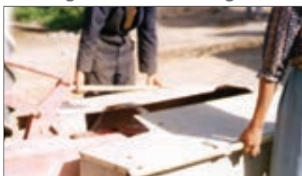
شکل ۶- پیاده کردن حفاظ
