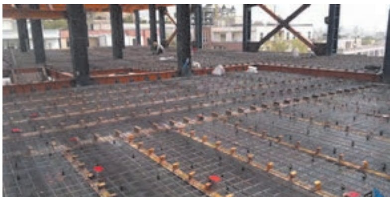
شکل ۳۲ ▲ سقف مرکب به همراه برشگیرها
