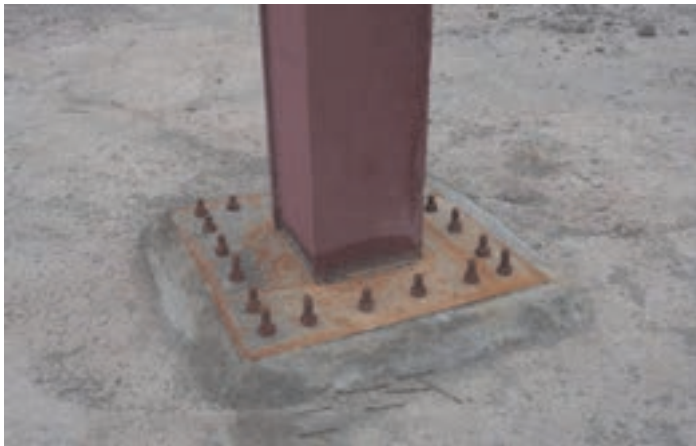
شکل ۴۹ ▲ اتصال مستقیم ستون به کف ستون
