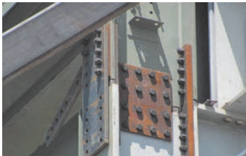
شکل ۵۷ وصله پیچی ستون
