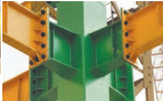
شکل ۵۰ ▲ انواع اتصال فلنجی
