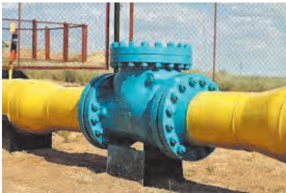
شکل ۵۰ ▲ انواع اتصال فلنجی
