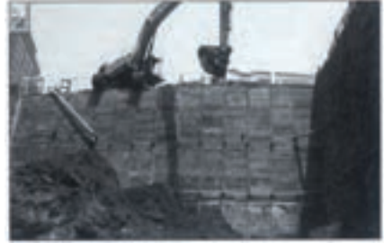
شکل ۱- ضرورت رعایت ایمنی در عملیات گودبرداری
