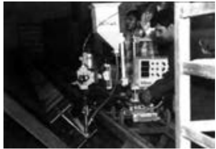
جوشکاری زیر پودری
