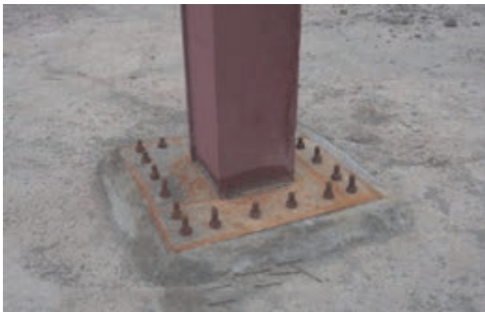
شکل ۴۹ ▲ اتصال مستقیم ستون به کف ستون
