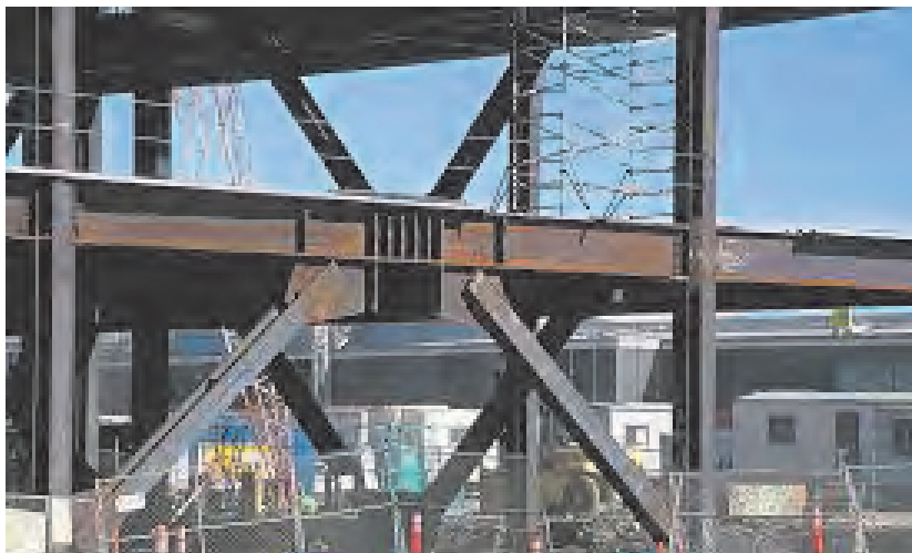
شکل ۲۷ ▲ مهاربند ذوزنقه‌ای
