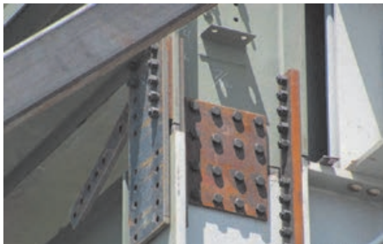
شکل ۵۷ وصله پیچی ستون
