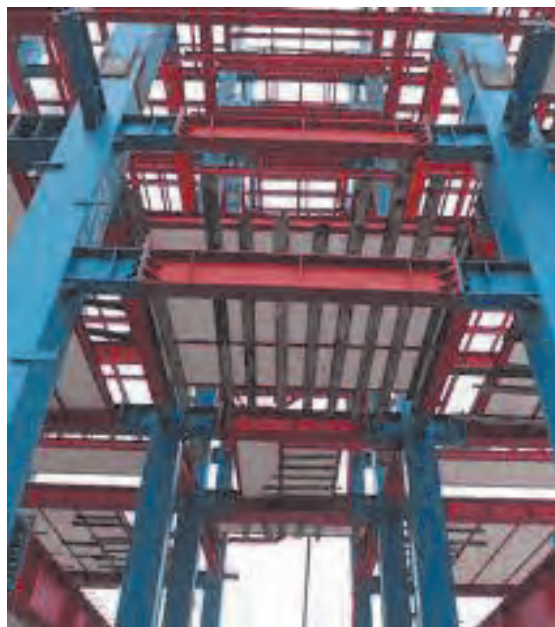
شکل ۶۰ ▲ قاب خمشی
