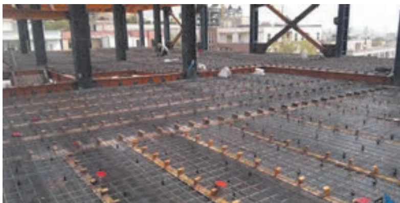
شکل ۳۲ ▲ سقف مرکب به همراه برشگیرها
