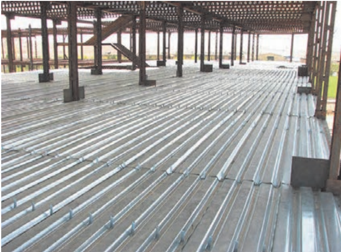
شکل ۳۳ ▲ سقف عرشه فولادی
