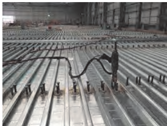
شکل ۳۴ ▲ روش نصب گل‌میخ روی سقف عرشه فولادی
