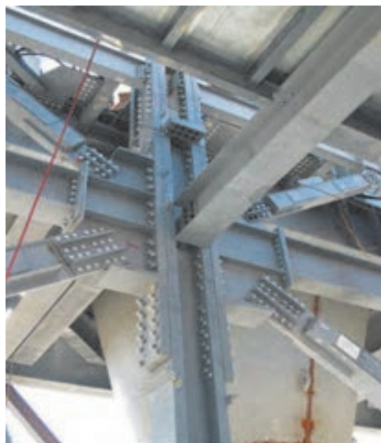
شکل ۵۱ ▲ اتصال مهاربندی
