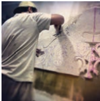
شکل ۳۵-۲- مراحل اجرای گچ‌بری به شیوه درجا
