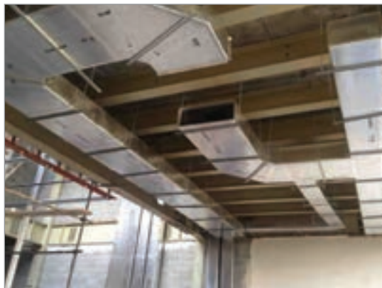
شکل ۱۹-۲- سقف با کانال تأسیساتی
