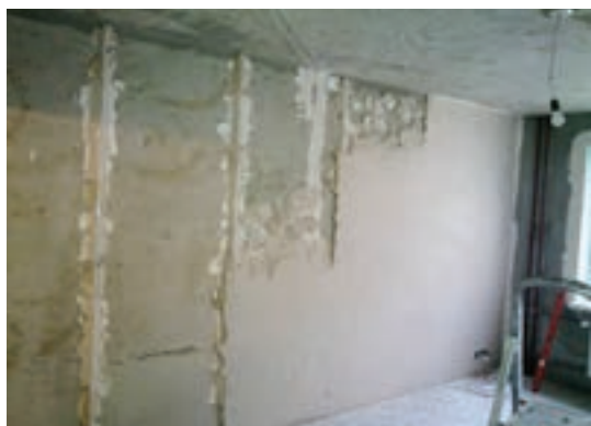
شکل ۱۳-۲ الف و ب) شمشه کشی بین کرم ها
