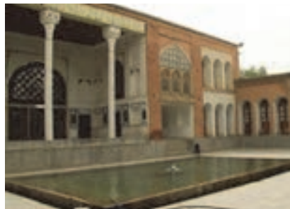
شکل ۴۴-۲- ایوان یک خانه سنتی در سنندج
