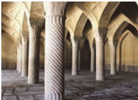
شکل ۲-۱۰۳- شیراز، ستون سنگی مسجد وکیل
