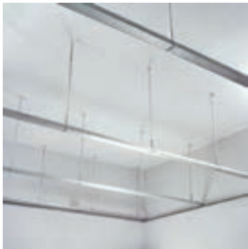
شکل ۳-۵۹- سازه‌های باربر تکمیل شده
