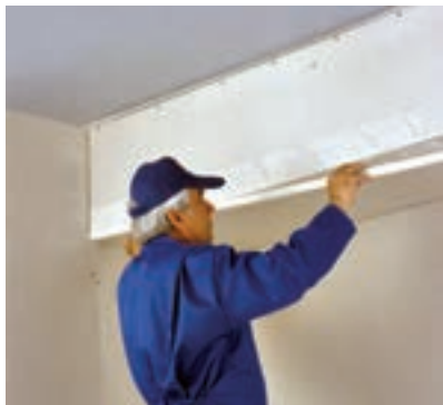
شکل ۸۴-۳- قرار دادن نوار درزگیر بر روی بتونه
