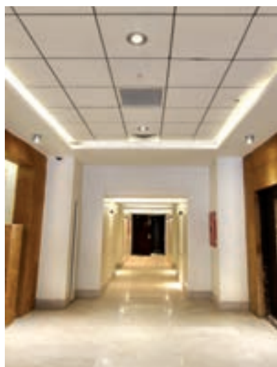
شکل ۹۳-۳- نمونه تمام شده سقف کاذب مشبک
