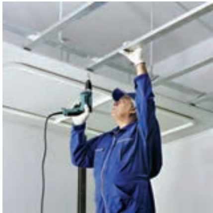
شکل ۳-۶۷ اتصال پانل به زیرسازی توسط پیچ
