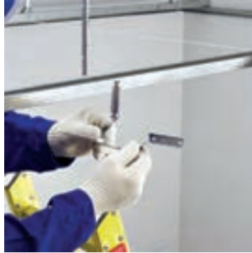
شکل ۳-۵۶- باز کردن رکاب
