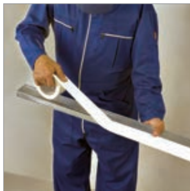
شکل ۸۵-۳- چسباندن نوار ترن فیکس بر روی سازه
