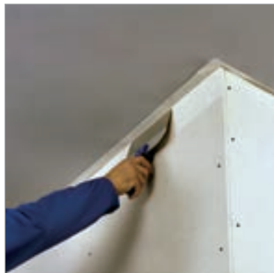
شکل ۳-۸۷- بتونه کاری در فصل مشترک دیوار خشک و سقف بتایی
