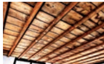
شکل ۳-۱- سقف کاذب چوبی
