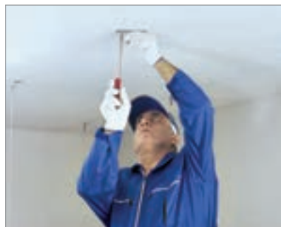
شکل ۱۱۶-۳- اتصال قطعه HT ۹۰ به سقف اصلی شکل ۱۱۷-۳
