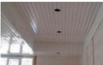
شکل ۳-۳- سقف کاذب فلزی
