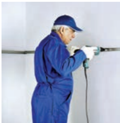
شکل ۳-۴۵- نصب سازه تراز
