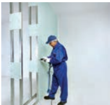
شکل ۹۸-۱- اجرای پانل‌ها در یک طرف دیوار
