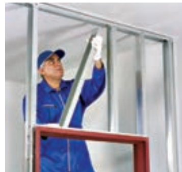
شکل ۱۳۱- استقرار استادهای کتیبه
