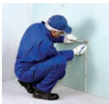
شکل ۱-۱۵۶- تعیین محل خروجی‌های تأسیساتی
