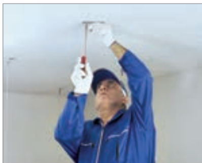
شکل ۳-۱۱۶ اتصال قطعه HT ۹۰ به سقف اصلی شکل ۳-۱۱۷
