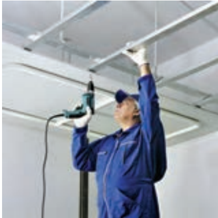
شکل ۳-۶۷ اتصال پانل به زیرسازی توسط پیچ
