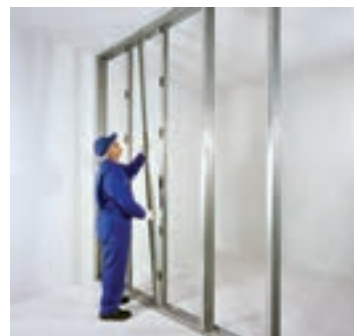
شکل ۸۴-۱- اجرای ردیف دوم استاده‌ها شکل ۸۵-۱- زیرسازی تکمیل شده شکل ۸۶-۱- اجرای پانل‌ها در یک طرف دیوار
