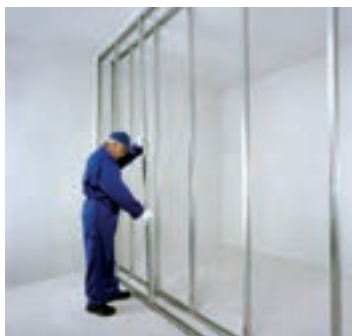
شکل ۹۶-۱. شاقولی کردن ردیف اول استادها
