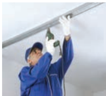
شکل ۴۸-۱ نصب رانر سقف
