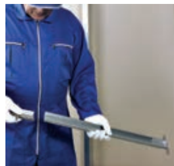
شکل ۱۶۷-۱ قطعه اتصال پشتیبان به صورت کشویی در سازه F۴۷ قرارداده می شود.
