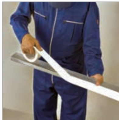
شکل ۸۵-۳- چسباندن نوار ترن فیکس بر روی سازه
