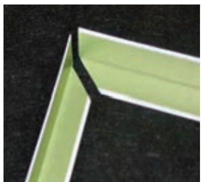
شکل ۱۰۹-۳ فارسی بر شدن نبشی تراز
