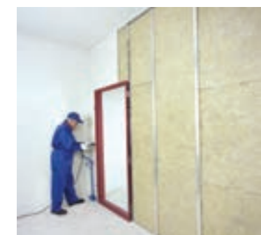
شکل ۱۳۸-۱- اجرای پانل اول دور چهارچوب
