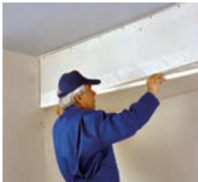
شکل ۸۴-۳- قرار دادن نوار درزگیر بر روی بتونه
