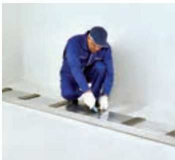
شکل ۸۲-۱- برش نوارهای عایق
