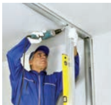
شکل ۱۱۶- نصب استاد اول شکل ۱۱۷- اتصال پایین استاد با پانچ شکل ۱۱۸- اتصال بالای استاد با پیچ LB
