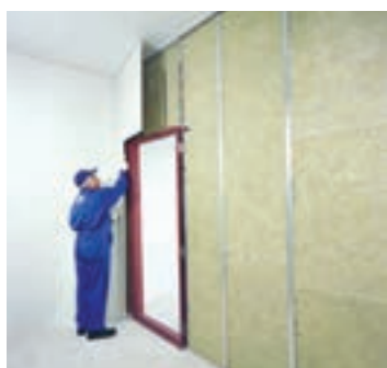
شکل ۱۳۹-۱- اجرای پانل دوم دور چهارچوب (پانل ها به شکل «L» برش داده می شوند).
