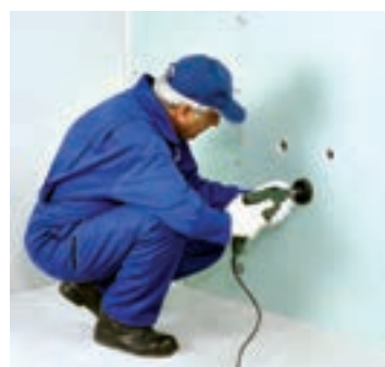
شکل ۱-۱۵۷- ایجاد خروجی‌های تأسیساتی به وسیله گردبر
