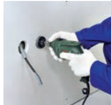
شکل ۱۷۳-۱ خروجی‌های تأسیساتی به وسیله گردبر ایجاد می‌شوند.
