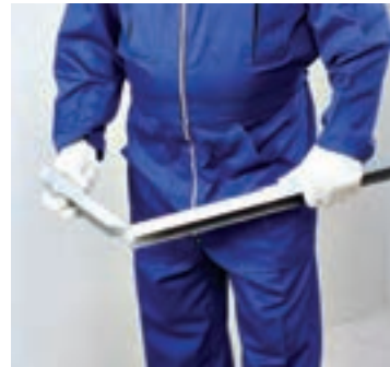
شکل ۱۲۸- خم کردن انتهای رانر نعل درگاه
