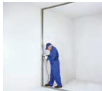
شکل ۱-۵۲- نصب استاد بر روی ساختار جانبی
