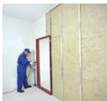
شکل ۱۳۸-۱- اجرای پانل اول دور چهارچوب
