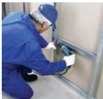
شکل ۱۶۸-۱ اتصال سازه پشتیبان به استاد های مجاور
