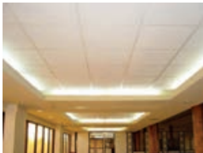
شکل ۱۱۰-۳- اجرای کامل سقف مشبک به روش قرینه‌سازی
