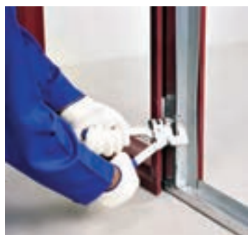
شکل ۱۱۹- استقرار چهارچوب در شکل ۱۲۰- نصب استاد دوم شکل ۱۲۱- اتصال پایین استاد با پانچ
