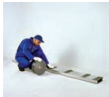
شکل ۸۱-۱- اجرای نوار عایق بر روی استاداها
