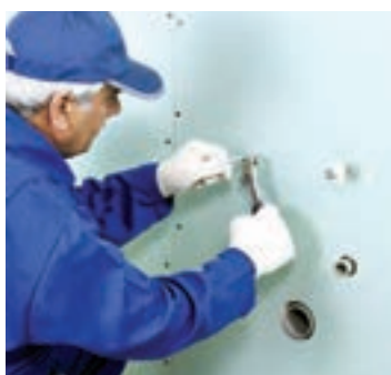
شکل ۱-۱۵۸- اتصال مهار روشویی به تراورس
