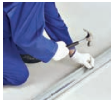
شکل ۴۲-۱- اتصال رانر به کف با رول پلاک
