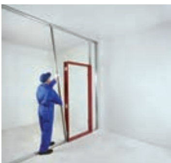
شکل ۱۱۹- استقرار چهارچوب در شکل ۱۲۰- نصب استاد دوم شکل ۱۲۱- اتصال پایین استاد با پانچ
