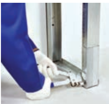
شکل ۱۱۶- نصب استاد اول شکل ۱۱۷- اتصال پایین استاد با پانچ شکل ۱۱۸- اتصال بالای استاد با پیچ LB
