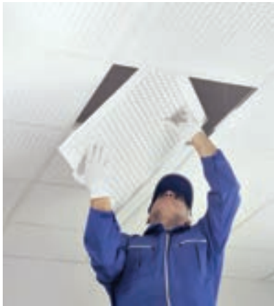
شکل ۳-۱۲۳- تایل گذاری شطرنجی جهت ایجاد نشست اولیه شکل ۳-۱۲۴- نحوه عبور تایل از میان سازه‌ها
