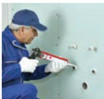
شکل ۱-۱۵۹- اجرای خمیر درزبند در اطراف خروجی‌های تأسیساتی
