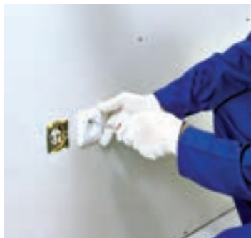
شکل ۸۷۱-۱ پس از نصب قوطی، پریز برق نصب می‌گردد.
