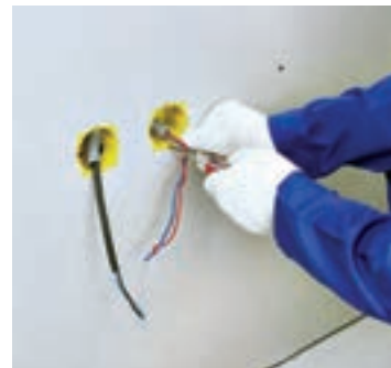
شکل ۱۷۶-۱ گیره‌ها توسط پیچ گوشتی جمع می‌شوند.
