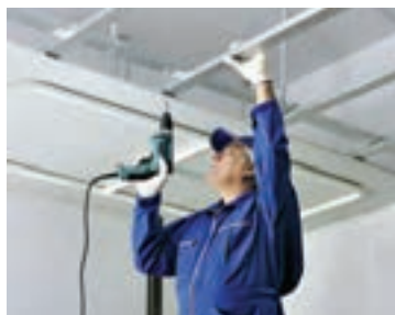
شکل ۳-۵- سقف کاذب با صفحات روکش دار گچی
