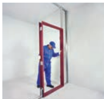
شکل ۱۱۹- استقرار چهارچوب در شکل ۱۲۰- نصب استاد دوم شکل ۱۲۱- اتصال پایین استاد با پانچ
