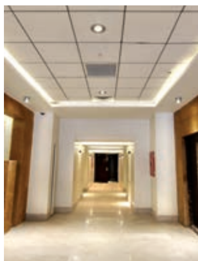
شکل ۹۳-۳ نمونه تمام شده سقف کاذب مشبک
