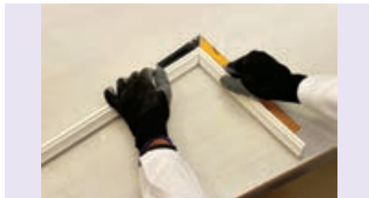
شکل ۲۲۹-۱ کنترل گونیا بودن قطعات قبل از نصب
