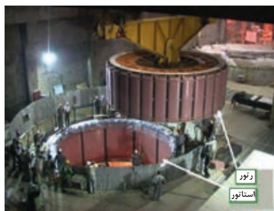
شکل ۱۳- رتور نیروگاه آبی سد شهید عباسپور در حال قرارگیری در استاتور
