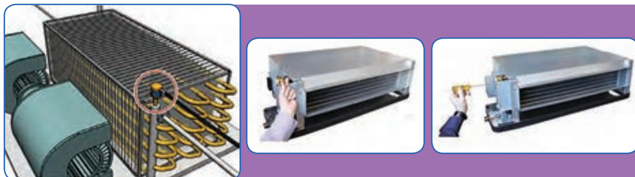
شکل ۲- هواگیری فن کویل
