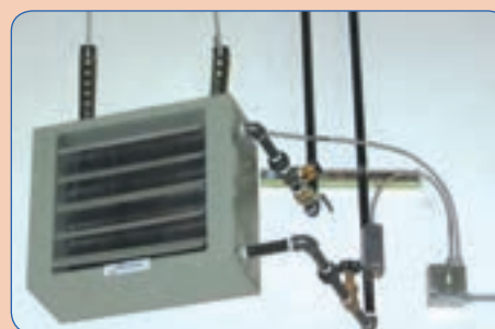
تفاوت طرح لوله‌کشی یونیت هیتر آب گرم و بخار
