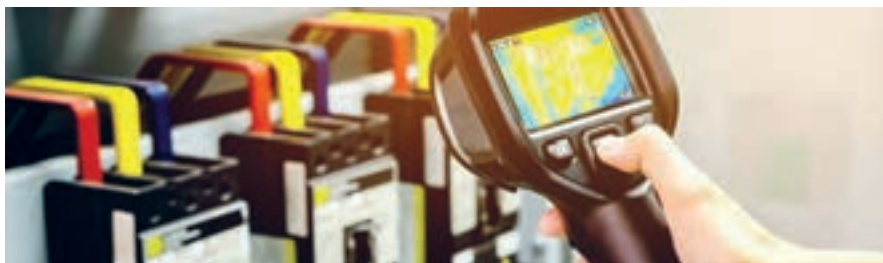
شکل ۲۱- سنجش دما در تجهیزات و قطعات آنها
