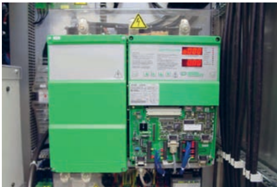
شکل ۴۴- یک درایور برای راه‌اندازی و کنترل موتور اصلی دستگاه چاپ
