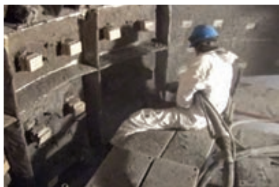
شکل ۲۸- نصب جرم با روش پاشش
