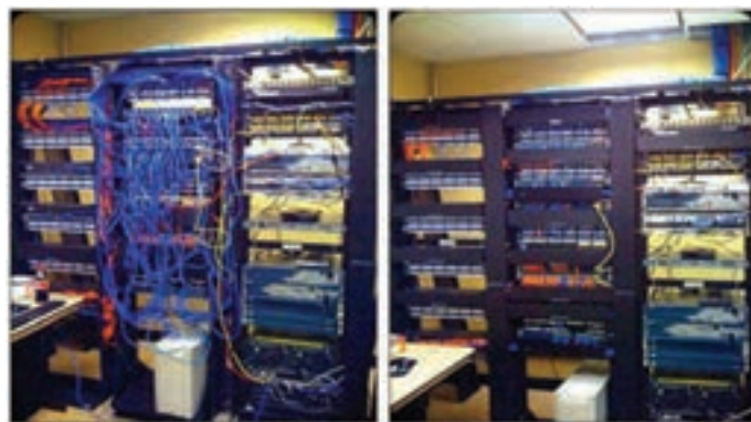
شکل ۴۱- مرتب کردن کابل‌ها
