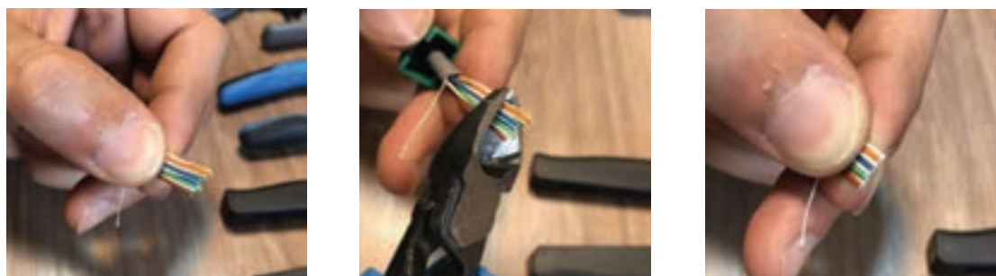
شکل ۲۷- مرتب کردن سیم‌های رنگی مطابق استاندارد
