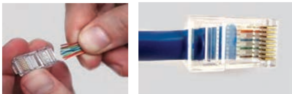
شکل ۲۸- قرار دادن سیم‌ها در سوکت
