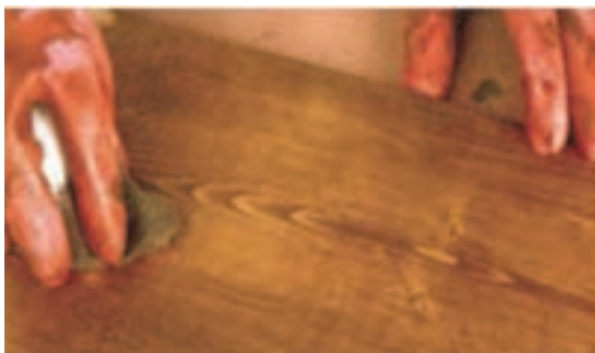
شکل ۱۴۴- زدن آستری هم رنگی با پارچه
