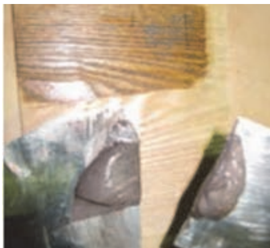
شکل ۱۳۸- برداشتن بتونه
