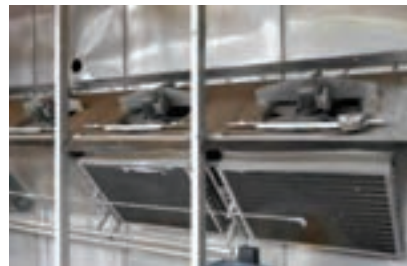
شکل ۴۰- انتقال حرارت کویل‌ها به وسیله فن‌ها
