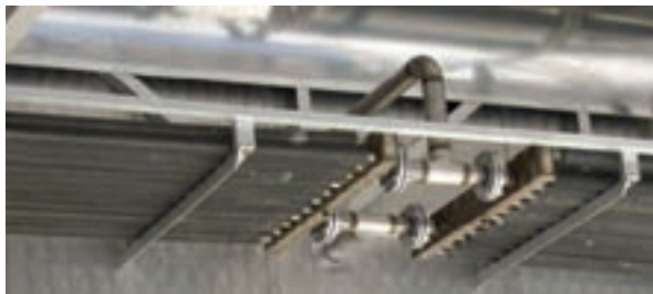
شکل ۴۱- انتقال حرارت کویل‌ها با هوای اطراف خود
