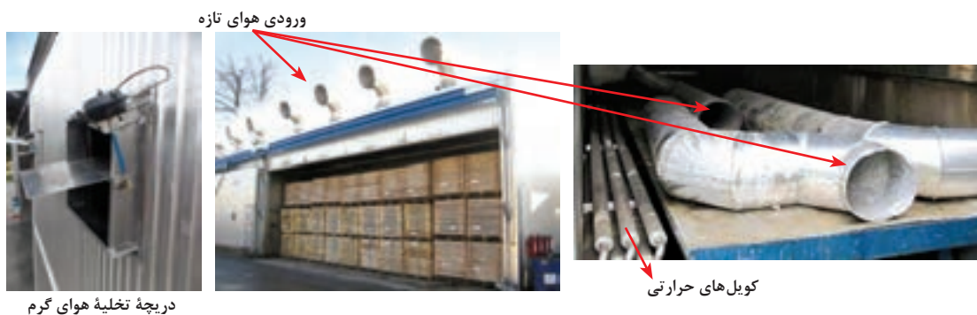
شکل ۴۲- دریچه‌های ورود هوای تازه در قسمت پایین کوره
