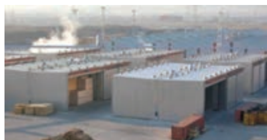
شکل ۲۹- کوره‌های چوب خشک‌کنی ساخته شده با آلومینیوم
