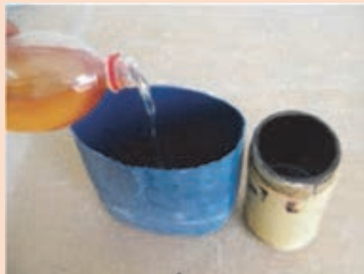
شکل ۷- رقیق کردن آستری قیری با بنزین
