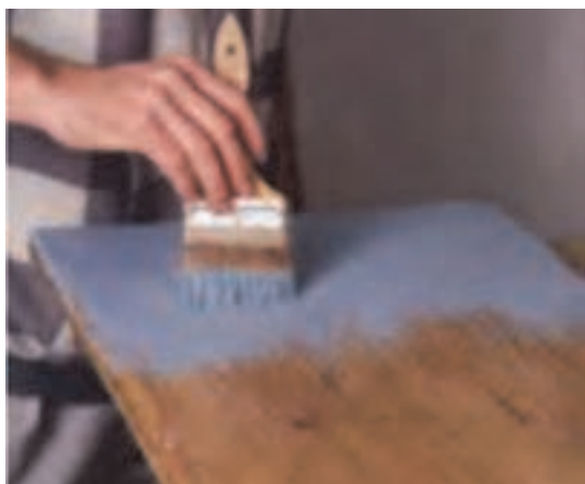
شکل ۲۱- زدن آستری یا قلم‌مو
