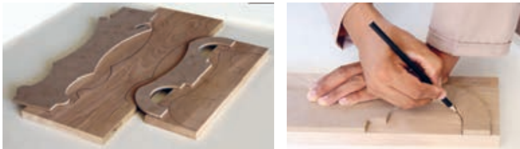
شکل ۸۰- انتقال الگوی تاج و پشتی، از روی شابلون به روی چوب
