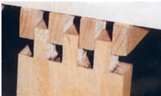
شکل ۱۲- اتصال انگشتی با تعداد زبانه فرد
