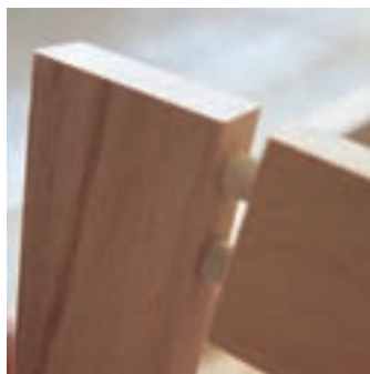
شکل ۱۱- اتصال دوبل (میخ چوبی)
