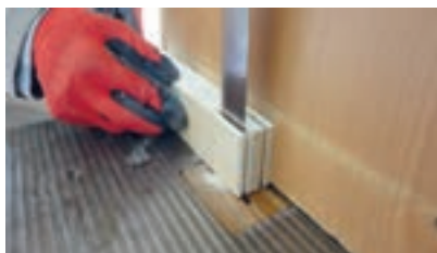
شکل ۹۰- عملیات برش زبانه با دستگاه اره نواری
