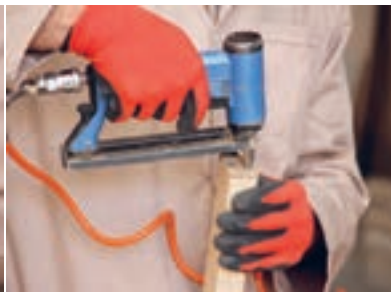
شکل ۱۱۱- مراحل نصب فیبر ۳ میلی متر با منگنه کوب
