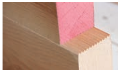
شکل ۱۳- اتصال انگشتی ساخته شده با دستگاه فرز
