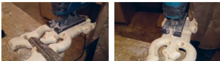
شکل ۶۸- برش طولی مفصل با اره عمودبر
