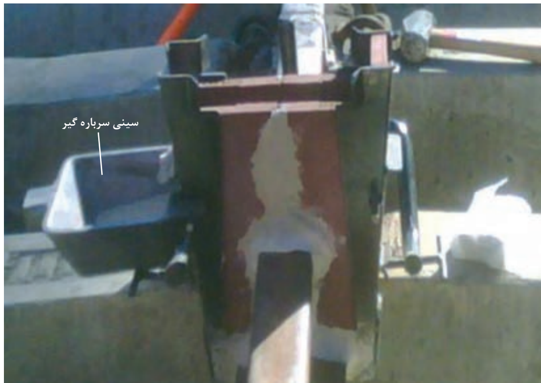
شکل ۲۰- نصب سینی‌های سرباره گیر
