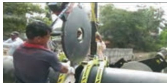
شکل ۱۹- جوشکاری لب به لب Butt Fusion
