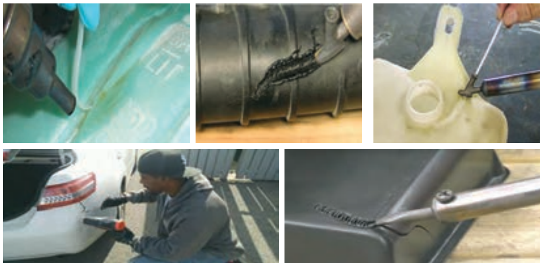
شکل ۲۳- جوشکاری تعمیری قطعات پلاستیکی
