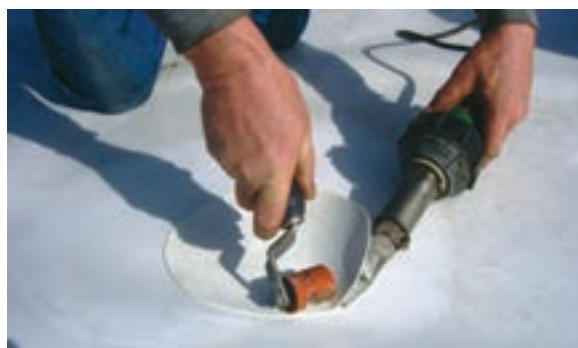
شکل ۱۲- جوشکاری با گاز داغ به صورت دستی
