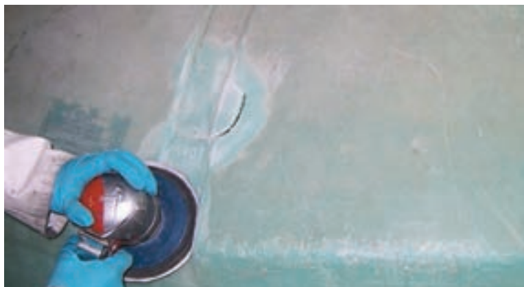
شکل ۲۷- آماده‌سازی سطوح پلاستیکی قبل از جوشکاری
