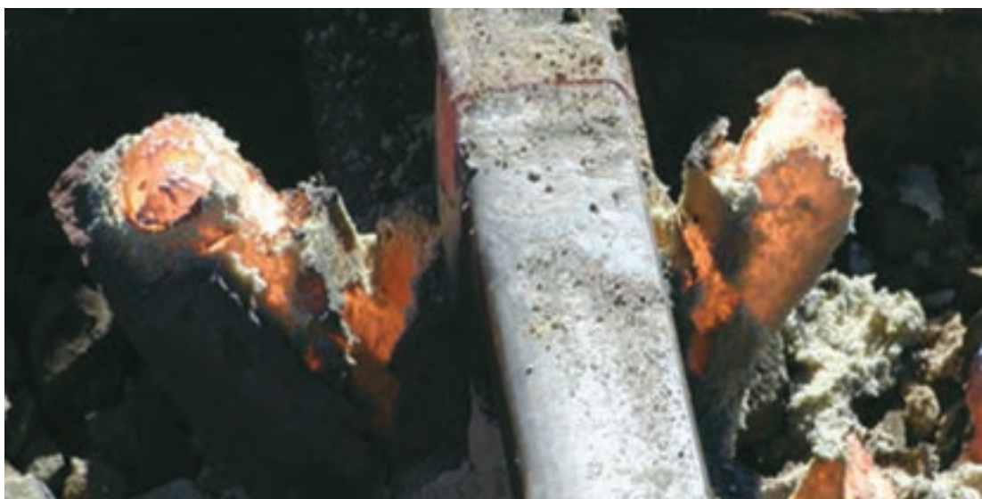
شکل ۲۷- برش گرده اضافی جوش
