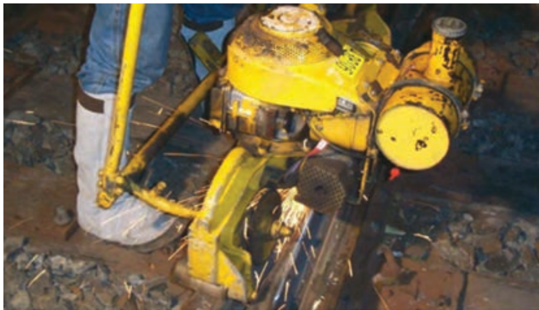
شکل ۲۸- سنگ زنی و پرداخت کاری سطح گرده
