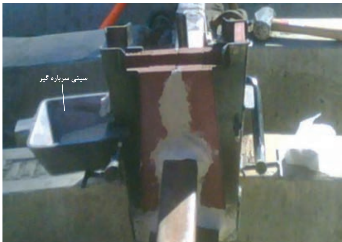
شکل ۲۰- نصب سینی‌های سرباره گیر
