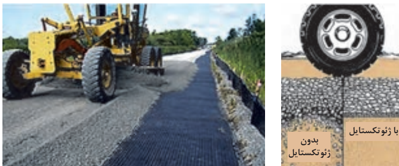
شکل ۲۵- کاربرد پارچه‌های ژئوتکستایل در زیرسازی راه
