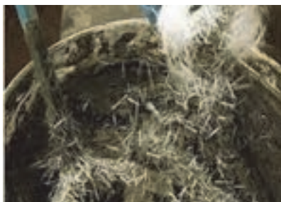
شکل ۱۸- استفاده از الیاف شیشه در مخلوط سیمان
