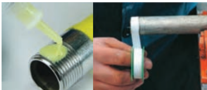
لوازم آب‌بندی اتصالات و لوله‌ها
