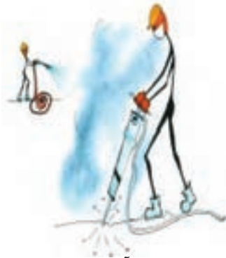
استفاده از اسپری آب جهت کاهش گردوغبار
