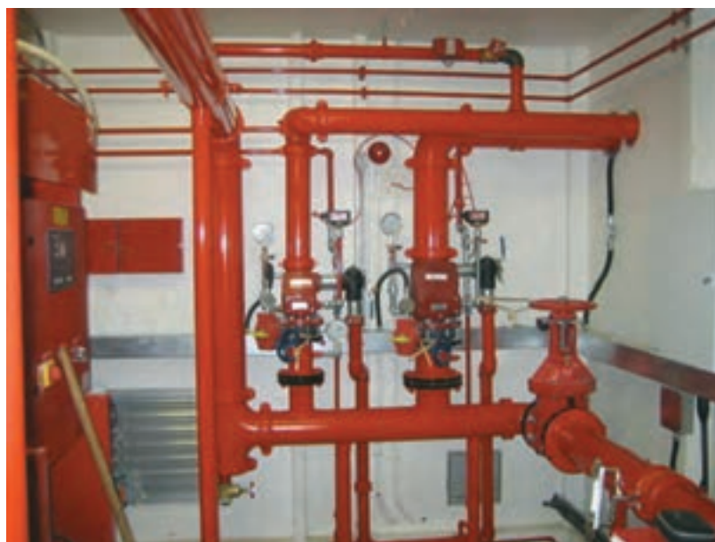
شکل ۱۰- قسمتی از سامانه آتش‌نشانی یک شناور
