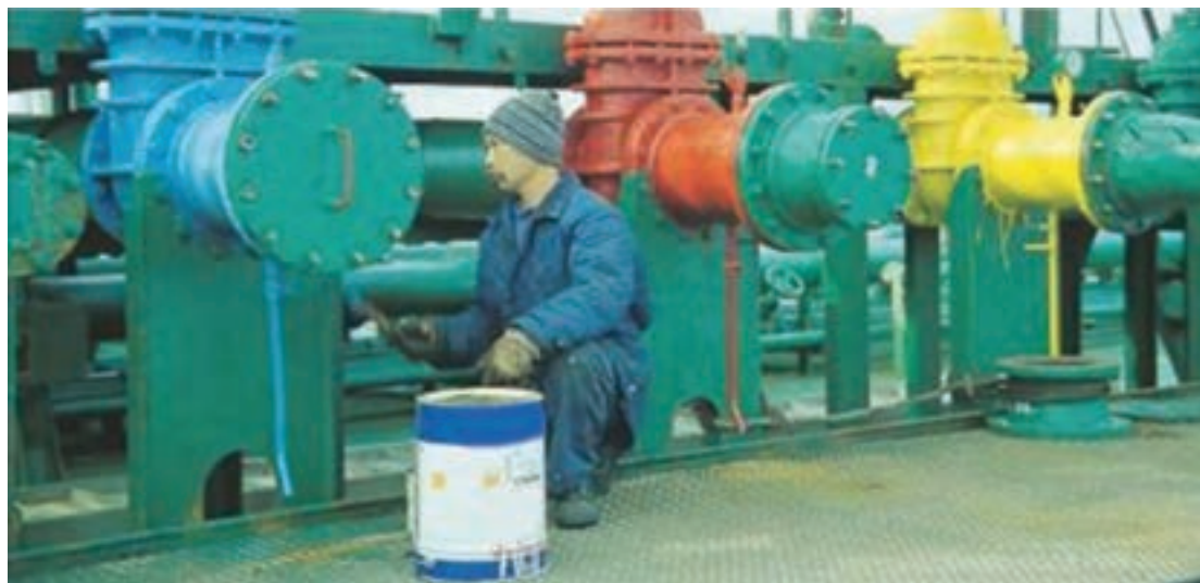
شکل ۵۵- رنگ آمیزی سامانه‌های لوله‌کشی بر روی عرشه
