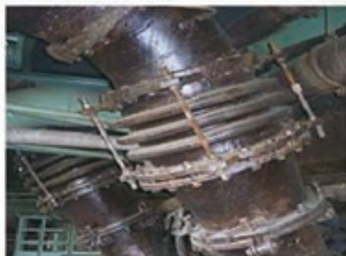
شکل ۴۳- اتصال‌های قابل انبساط
