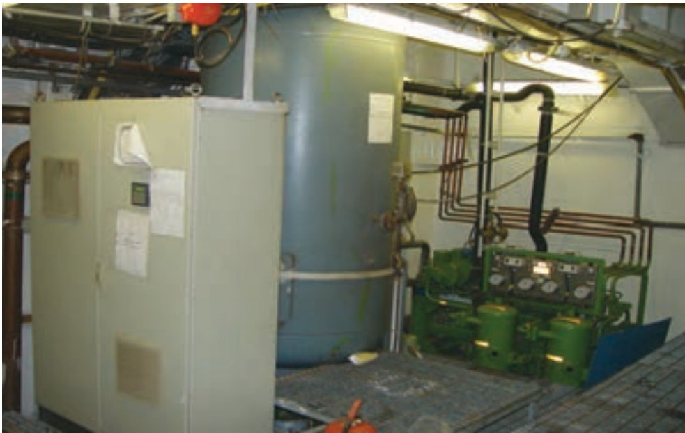
شکل ۱۷- سامانه هوای فشرده
