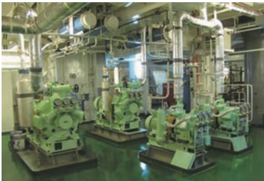
شکل ۱۹- کمپرسورهای هوا در ساختمان کشتی
