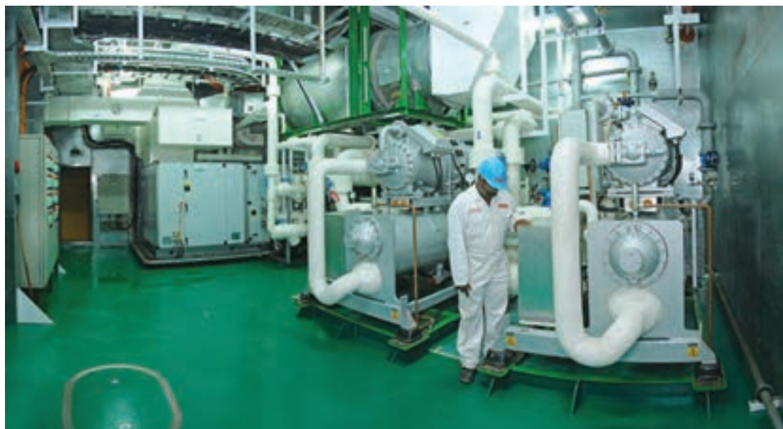
شکل ۲- نمونه‌ای از سامانه تهویه مطبوع در شناور
