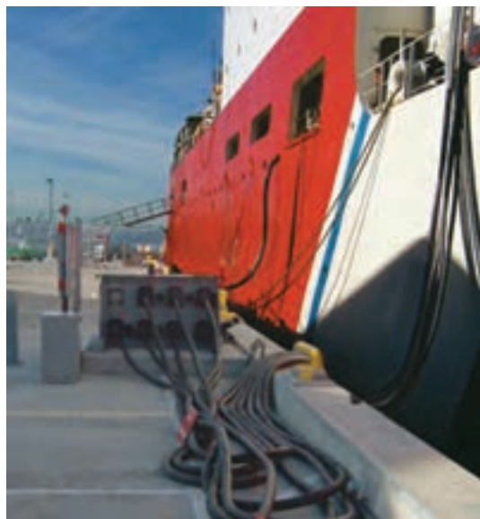
شکل ۲۵- استفاده از برق اسکله در زمان پهلوگیری شناور
