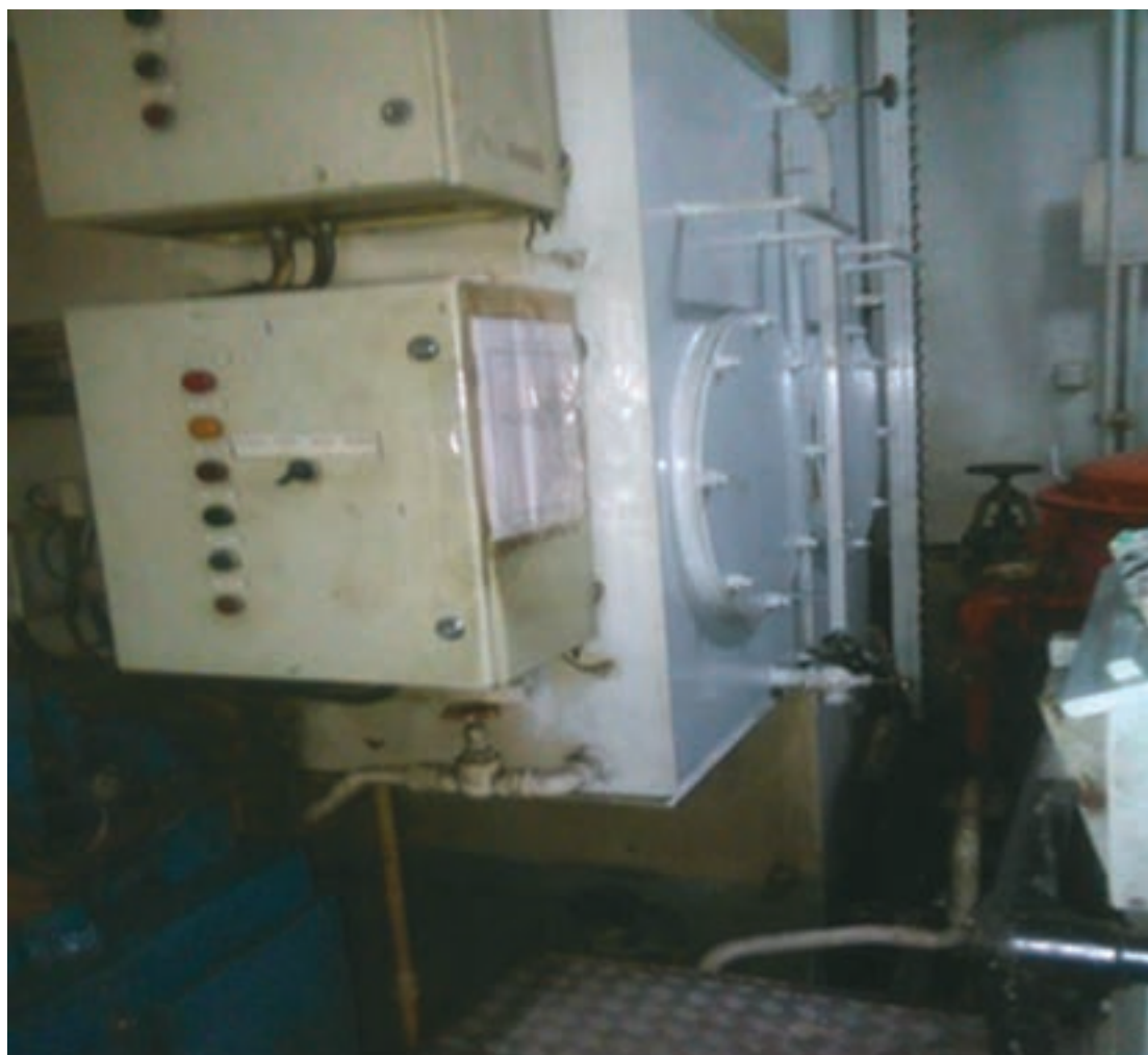
شکل ۲۳- مخزن سوخت روزانه یک شناور
