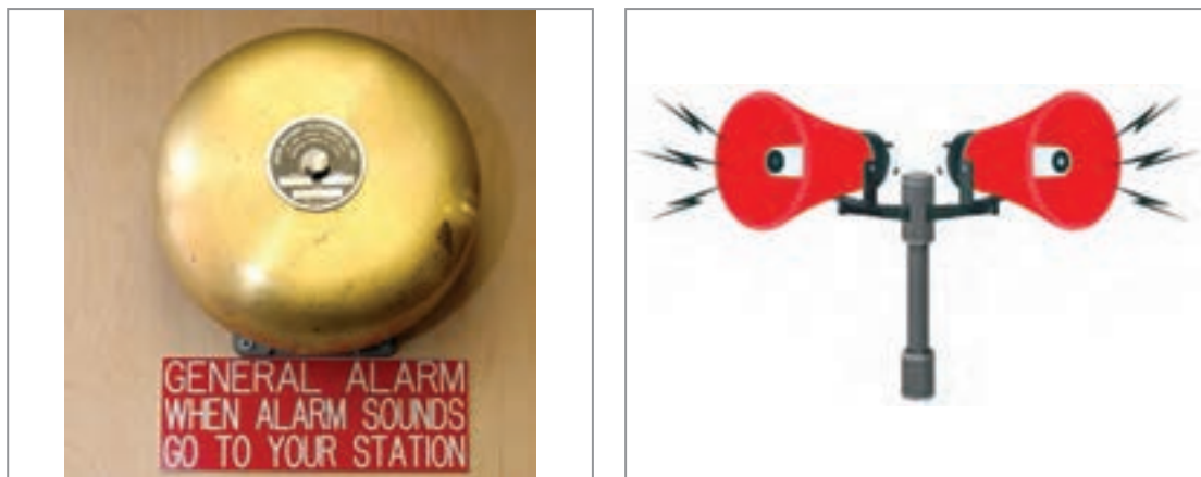
شکل ۱۳- سیستم اخطار شناور
